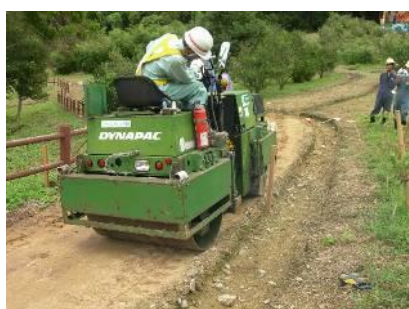
⑦路面の整地
