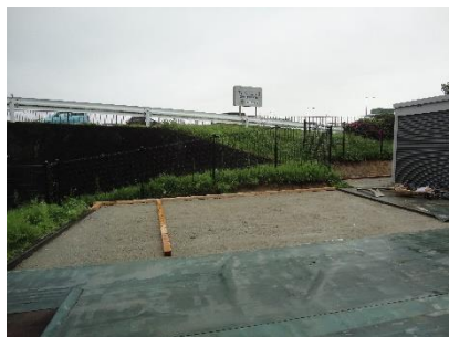
①型枠設置
