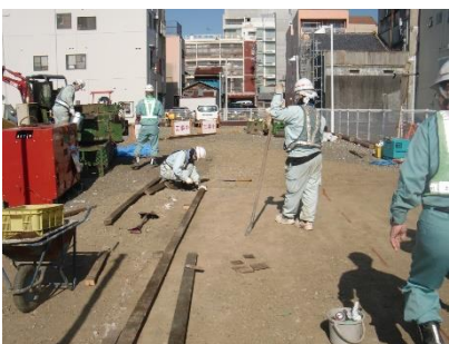
⑤型枠設置
