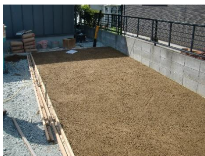
①敷均し状況
