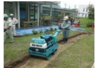
(d) 路床転圧(1t ローラ)
