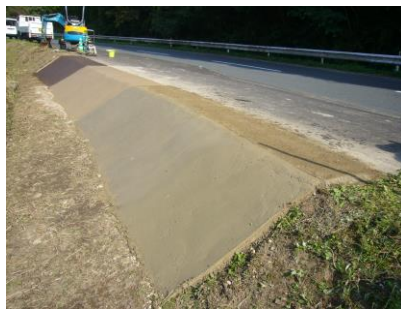
⑤仕上がり
