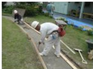
(i) 型枠設置
