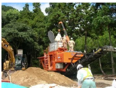
⑤固化材の投入
