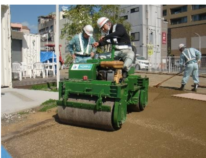
⑧一次転圧
