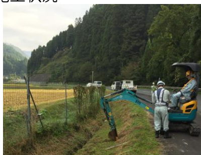
①掘削・床付け
