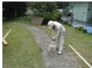
(f) 路盤敷均し
