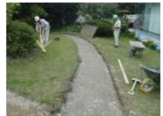
(h) 路盤完了
