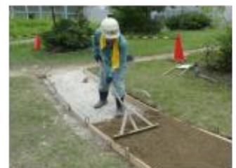
(l) 表層敷均し
