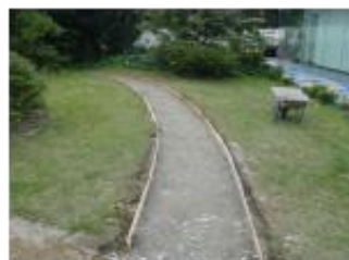
(j) 型枠設置完了
