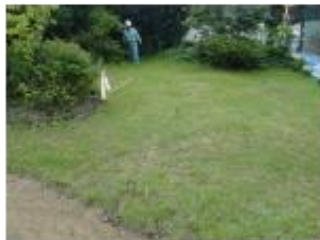
(a) 施工前全景
