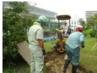
(b) 掘削状況
