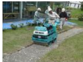
(g) 路盤転圧(1t ローラ)
