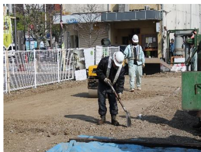
④不陸整正・転圧状況
